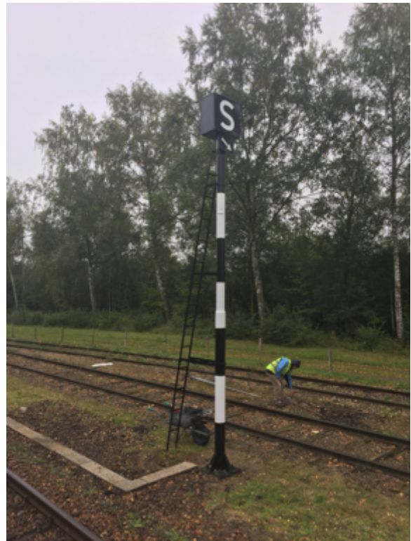
De lantaarn wordt aangebracht op de seinpaal, waarna het eindresultaat zichtbaar is en het sein in dienst kon worden gesteld, 7 oktober 2017 (foto's: M. Noorhoff en P.P. van Birgelen).
