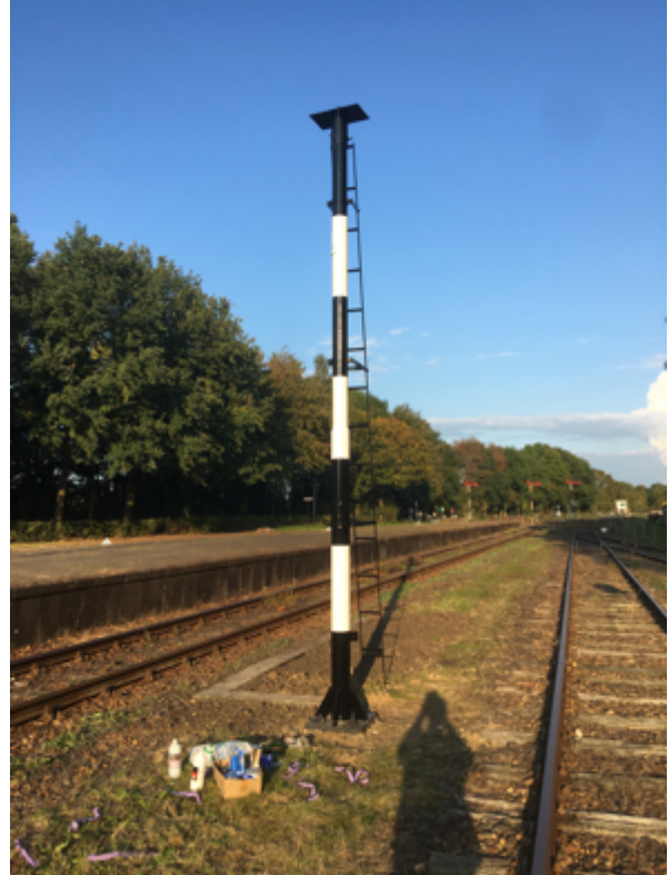
Met behulp van de railkraan wordt op 2 september 2017 de seinpaal geplaatst aan de oostzijde van spoor 4. Rechts op de foto zien we nog net het stopseinbord staan. Een paar weken later staat de paal strak in de lak klaar voor montage van de lantaarn (Foto's: P.P. van Birgelen).
