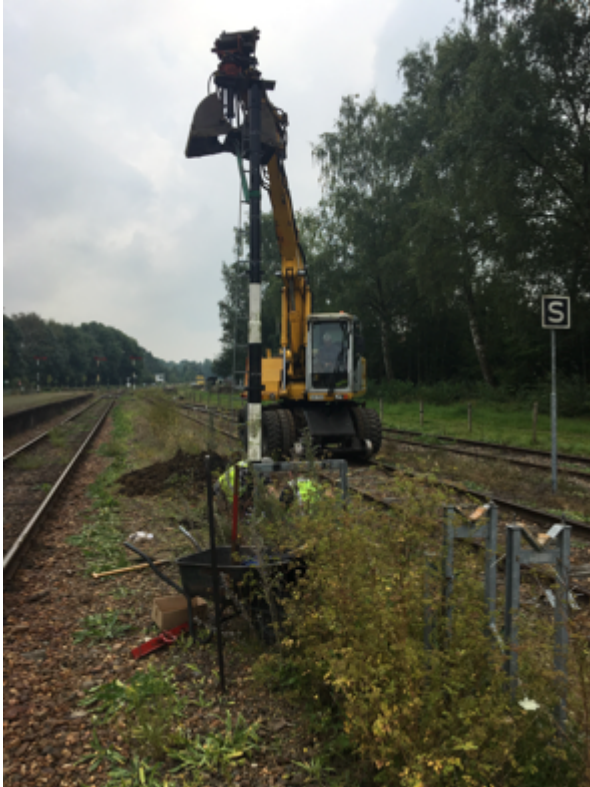
Met behulp van de railkraan wordt op 2 september 2017 de seinpaal geplaatst aan de oostzijde van spoor 4. Rechts op de foto zien we nog net het stopseinbord staan. Een paar weken later staat de paal strak in de lak klaar voor montage van de lantaarn (Foto's: P.P. van Birgelen).
