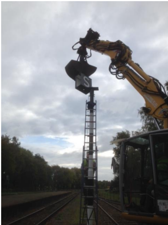
De lantaarn wordt aangebracht op de seinpaal, waarna het eindresultaat zichtbaar is en het sein in dienst kon worden gesteld, 7 oktober 2017 (foto's: M. Noorhoff en P.P. van Birgelen).
